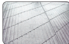
3. 단열재 시공 기포 콘크리트, 스티로폼 위에 단열재 시공
