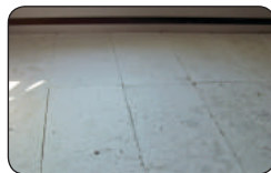
2. 스티로폼 시공 기포 콘크리트 시공이 안됐을 시 시공
