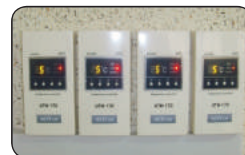
9. 온도조절기 설치 전원(220V)을 연결 작동상태 점검
